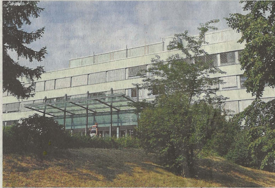
Das Krankenhaus Weißwasser behandelte 2020 rund 600 Kinder stationär. Foto: Archiv/jr
